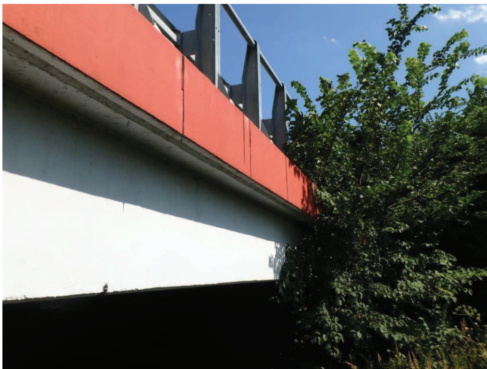
Fot. 44. Widoczna bujna wegetacja roślin i drzew zagrażająca konstrukcji obiektu. Od górnej wody od strony m. Ogonowice
