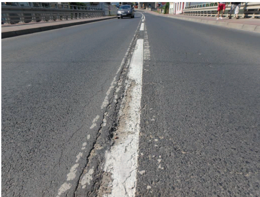
Fot. 8. Drobne ubytki i wykruszenia oraz spękania w obrębie styku technologicznego jezdni ułatwia wnikanie wody w konstrukcję nawierzchni co przyspiesza procesy degradacyjne. Uszkodzenie występuje na całej długości jezdni i dojazdów
