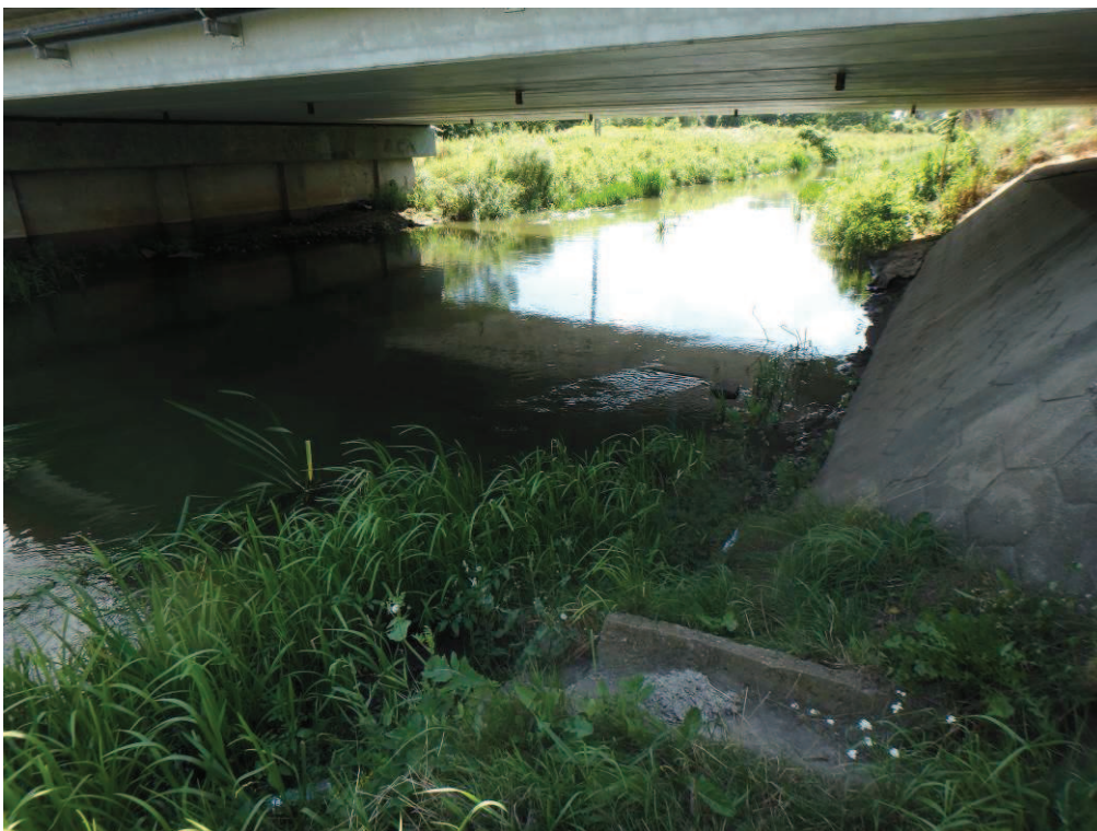
Fot. 39. Brak regulacji cieku pod obiektem powodować może podmycia skarp oraz filara. Widok od strony dolnej wody
