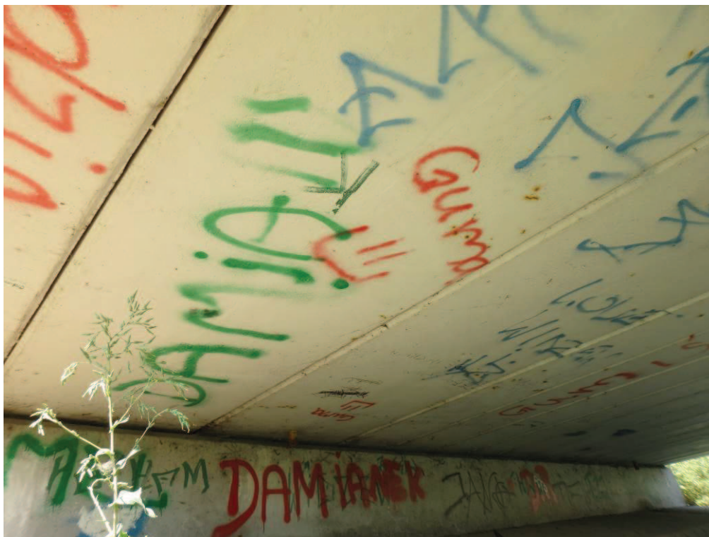
Fot. 31. Rozległe zanieczyszczenia powierzchni betonu w postaci graffiti spowodowane aktami wandalizmu. Od strony Opoczna. Podobne uszkodzenia występują lokalnie na obu przęsłach
