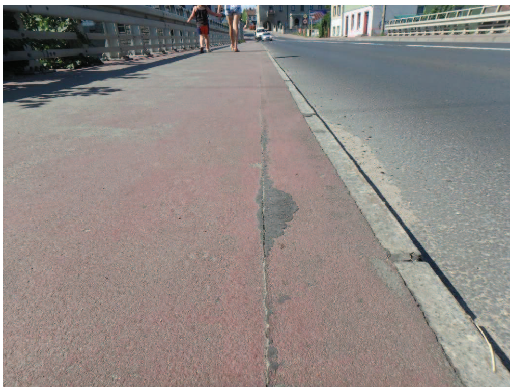
Fot. 16. Widoczne spękania żywicznych nawierzchni chodnika spowodowane najprawdopodobniej nieszczelnościami lub błędami wykonawczymi. Uszkodzenia występują lokalnie na całej długości chodników. Od górnej wody.
