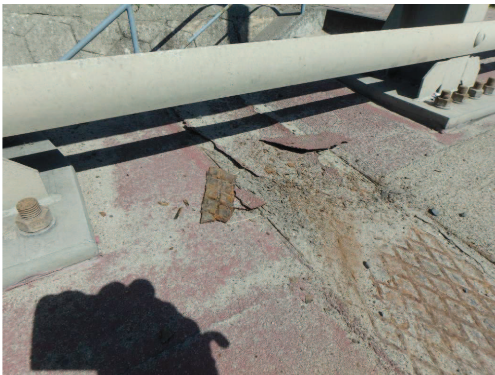
Fot. 24. Widoczna zaawansowana korozja o charakterze wżerowym blach osłonowych w obrębie gzymsów. Od dolnej wody.
