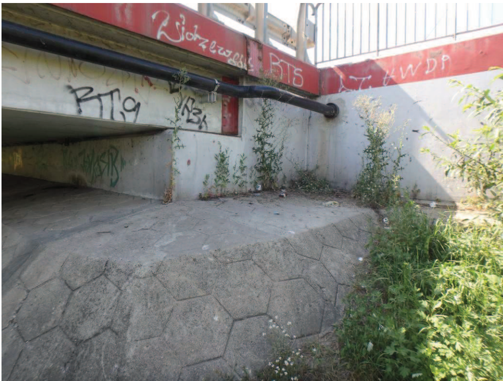
Fot. 38. Widoczna drobna wegetacja roślinności na umocnionych skarpach. Dodatkowo widoczne zanieczyszczenia powierzchni betonu w postaci graffiti spowodowane aktami wandalizmu. Od strony Opoczna.
