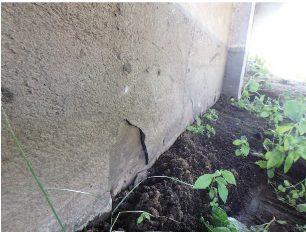
Fot. 37. Ubytki i odspojenia przypowierzchniowych warstw naprawczych betonu filara. Uszkodzenia powstały prawdopodobnie na skutek zawilgoceń powierzchni betonowych przez nurt cieku.
