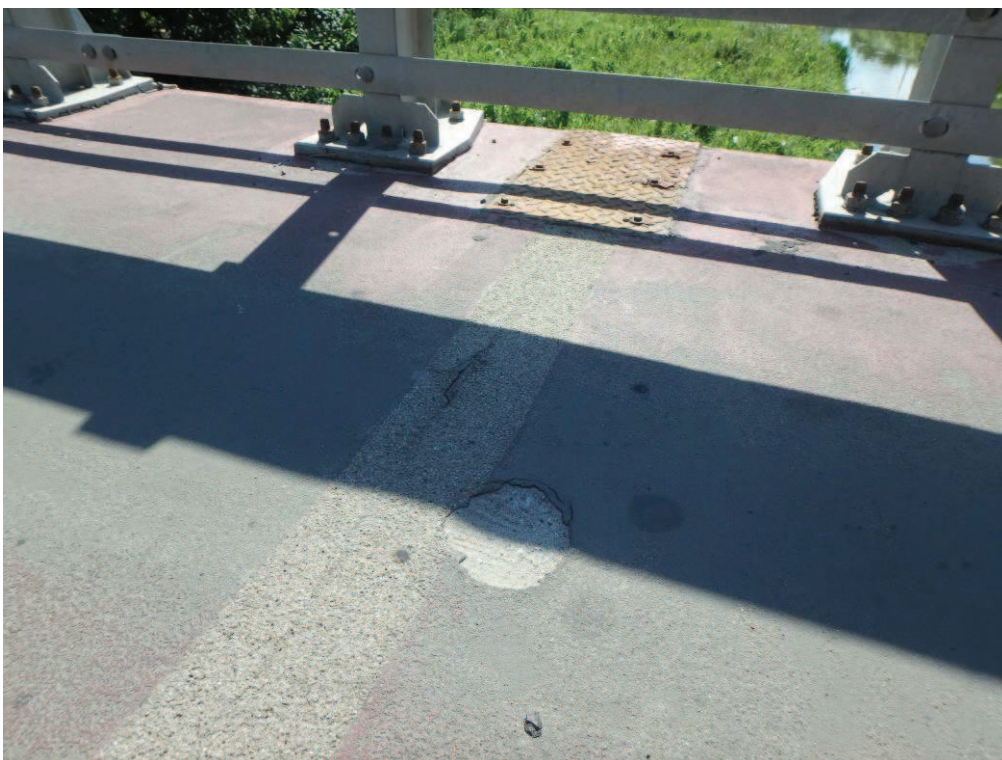
Fot. 22. Widoczne poprzeczne spękania oraz ubytki w obrębie chodnika nad podporą pośrednią spowodowane brakiem zdylatowania kapy chodnikowej. Widoczne wykonywane naprawy nie przyniosły poprawy sytuacji. Widoczna korozja blach osłonowych w obrębie gzymsów. Od górnej wody.
