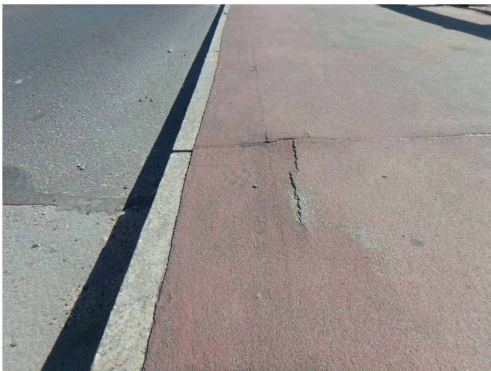
Fot. 14. Widoczne spękania i odspojenia żywicznych nawierzchni chodnika spowodowane najprawdopodobniej nieszczelnościami lub błędami wykonawczymi. Uszkodzenia występują lokalnie na całej długości chodników. Od górnej wody.
