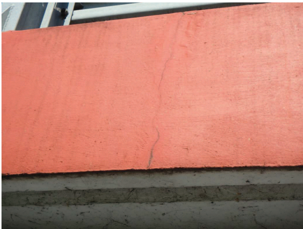
Fot. 28. Widoczne pionowe spękania gzymsów spowodowane najprawdopodobniej skurczem betonu. Od górnej wody. Uszkodzenia występują prawie na całej długości gzymsów.
