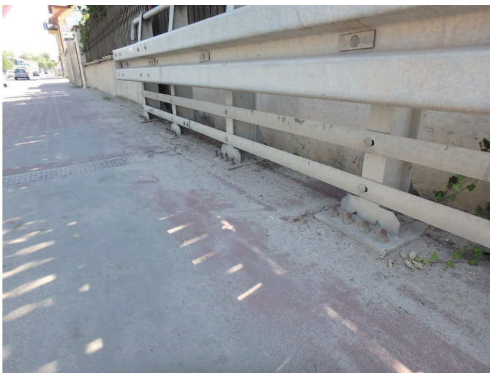
Fot. 17. Widoczne zanieczyszczenia nawierzchni chodnika materiałem ziemnym. Uszkodzenia występują i powstały na skutek braku prac z zakresu bieżącego utrzymania. Od górnej wody od m. Ogonowice.
