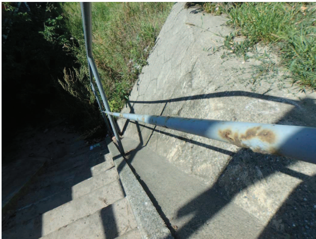
Fot. 40. Widoczne pojedyncze ogniska korozji stalowych elementów balustrad schodów skarpowych spowodowane zniszczeniem powłok antykorozyjnych balustrady. Od dolnej wody.
