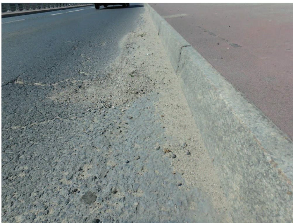
Fot. 11. Widoczne drobne zanieczyszczenia nawierzchni jezdni materiałem ziemnym w obrębie strefy przykrawężnikowej. Widoczne deformacje w postaci skoleinowania jezdni występujące na całej długości obiektu.
