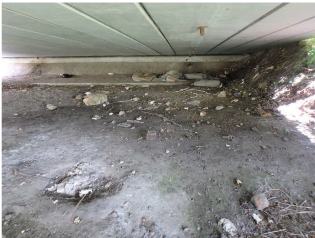
Fot. 45. Widoczne rozległe zanieczyszczenia terenu pod obiektem powstałe na skutek aktów wandalizmu. Dodatkowo widoczny grunt którym w sposób nieprawidłowy obsypano obiekt. Od górnej wody od strony m. Ogonowice
