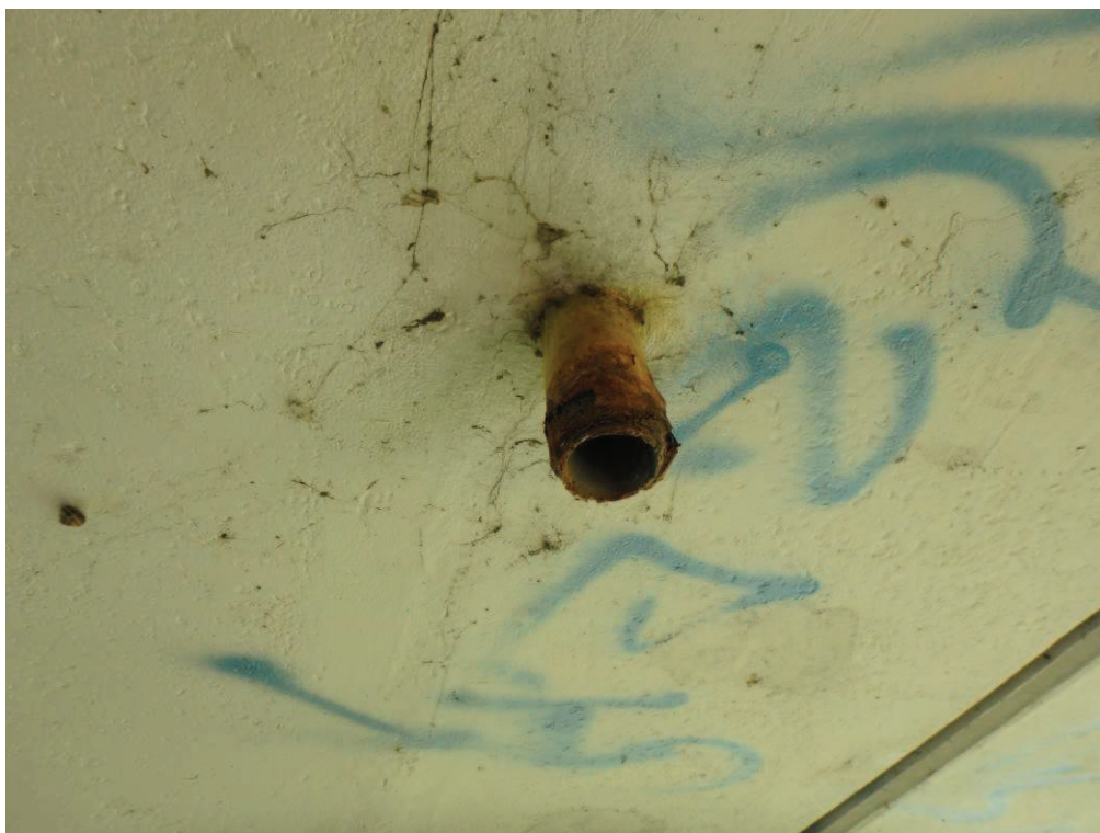
Fot. 30. Widoczna korozja stalowych elementów sączków odprowadzających wodę z izolacji. Uszkodzenie dotyczy wszystkich rur odpływowych na obiekcie.
