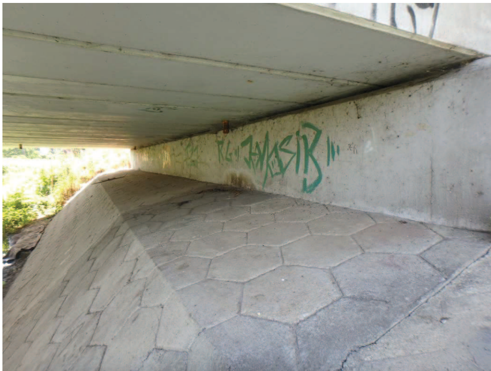
Fot. 34. Rozległe zanieczyszczenia powierzchni betonu w postaci graffiti spowodowane aktami wandalizmu. Od strony Opoczna.
