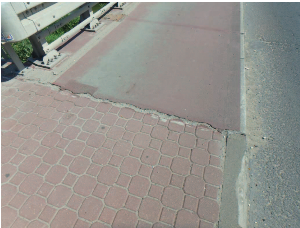
Fot. 18. Widoczne spękania, odspojenia oraz ubytki żywicznych nawierzchni chodnika spowodowane najprawdopodobniej nieuszczelniościami lub błędami wykonawczymi. Uszkodzenia występują lokalnie na całej długości chodników. Od dolnej wody.
