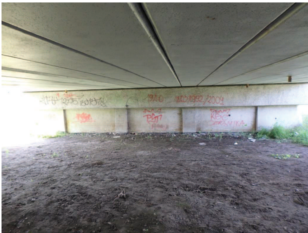
Fot. 35. Rozległe zanieczyszczenia powierzchni betonu w postaci graffiti spowodowane aktami wandalizmu. Filar od strony m. Ogonowice
