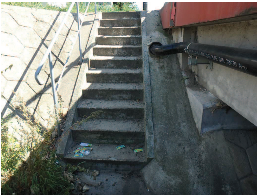
Fot. 41. Zanieczyszczenia materiałem ziemnym oraz innymi materiałami schodów skarpowych. Brak prac w zakresie bieżącego utrzymania. Od dolnej wody.
