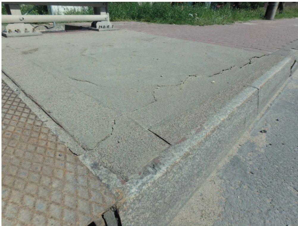
Fot. 12. Widoczne spękania oraz odspojenia żywicznych nawierzchni chodnika w obrębie dojeżdż spowodowane najprawdopodobniej nieszczelnościami lub błędami wykonawczymi. Uszkodzenia występują lokalnie na całej długości chodników. Od dolnej wody.
