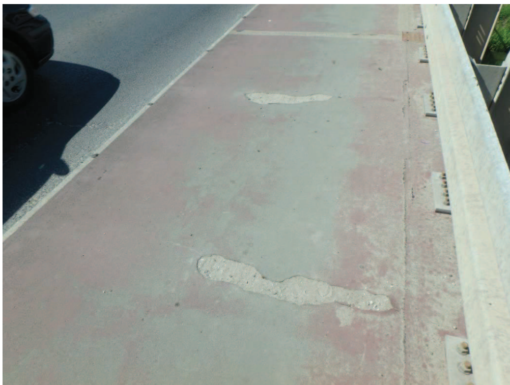
Fot. 13. Widoczne spękania, odspojenia oraz ubytki żywicznych nawierzchni chodnika spowodowane najprawdopodobniej nieszczelnościami lub błędami wykonawczymi. Uszkodzenia występują lokalnie na całej długości chodników. Od dolnej wody.
