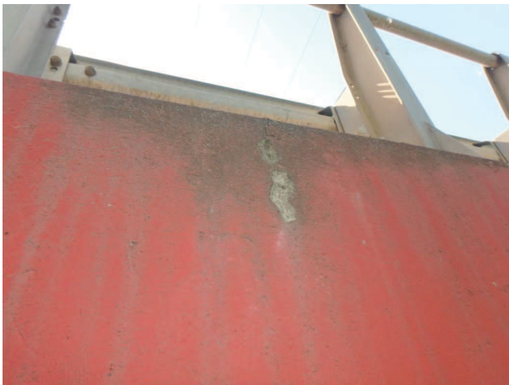
Fot. 26. Widoczne pionowe spękania gzymsów oraz zanieczyszczenia. Spękania spowodowane najprawdopodobniej skurczem betonu, natomiast zanieczyszczenia powstały na skutek zacieków wody z nawierzchni chodnika. Od dolnej wody. Uszkodzenia występują prawie na całej długości gzymsów.
