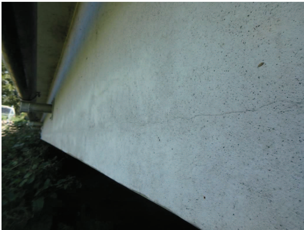
Fot. 32. Podłużna rysa o charakterze technologicznym na połączeniu skrajnej belki z nadbetonem. Uszkodzenie występuje na całej długości przęsła po obu stronach obiektu. Od dolnej wody.
