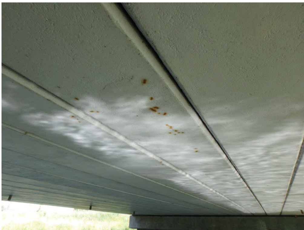
Fot. 29. Widoczne pojedyncze rdzawe wykwity na spodzie belek prefabrykowanych powstałe prawdopodobnie na etapie prefabrykacji na skutek korozji drobnych stalowych elementów (opilki, druty wiązałkowe) pod powierzchnią dźwigara. Występują lokalnie na całej powierzchni przęsła.
