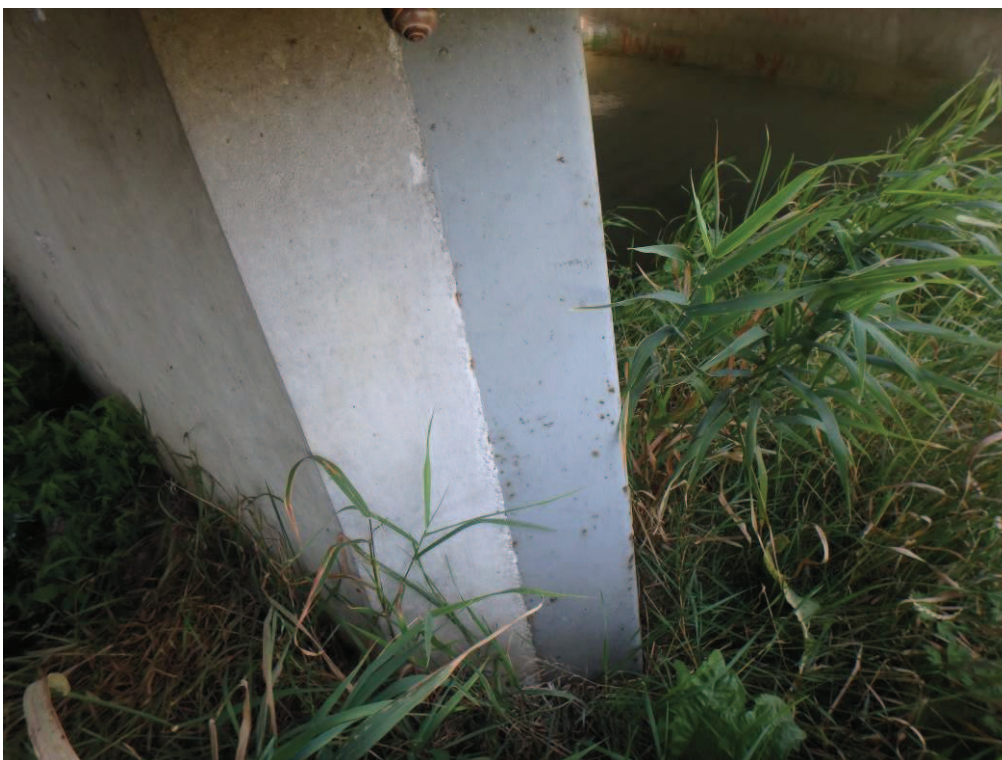
Fot. 36. Widoczne pojedyncze ogniska korozji stalowego okucia naroża filara, spowodowane uszkodzeniami powłok antykorozyjnych. Uszkodzenia występują po obu stronach filara. Od dolnej wody.
