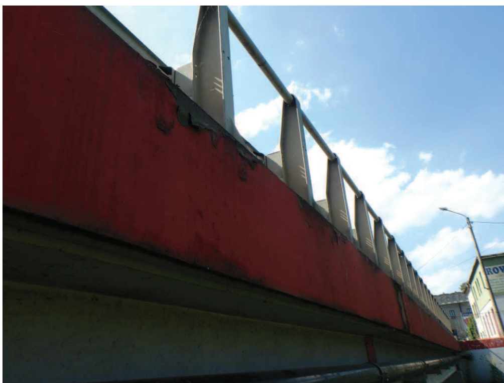
Fot. 27. Widoczne ubytki powłok ochronnych betony monolitycznych gzymsów. Uszkodzenia powstały prawdopodobnie na skutek zacieków wody z nawierzchni chodnika. Od strony dolnej wody. Uszkodzenia występują prawie na całej długości gzymsów.
