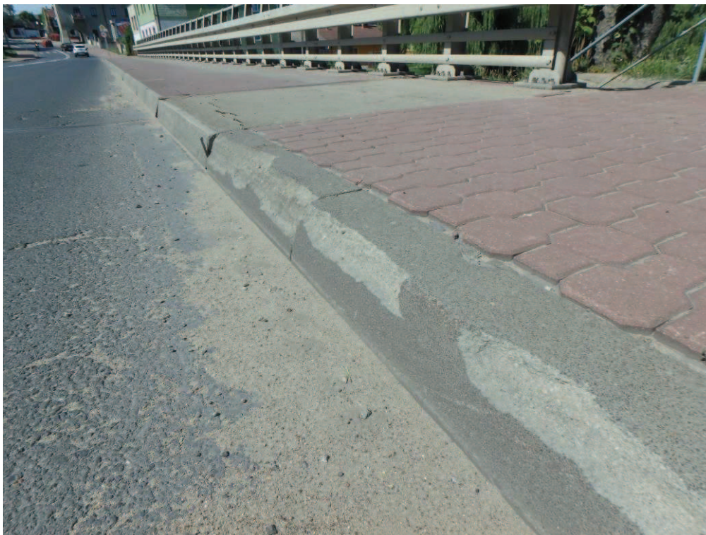
Fot. 7. Ubytki przypowierzchniowych warstw betonu krawężników na dojeździe. Uszkodzenie spowodowane niską jakością wykonanych krawężników oraz działaniem soli odmrażających stosowanych w okresie zimowym. Od strony m. Ogonowice
