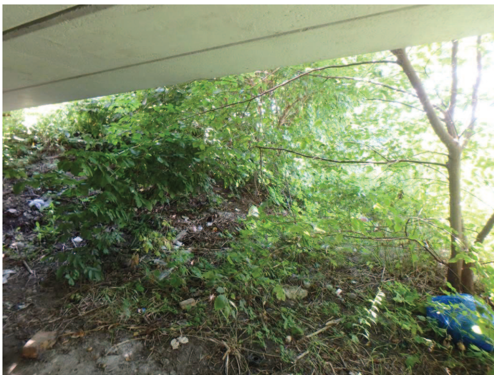
Fot. 43. Widoczna bujna wegetacja roślin i drzew zagrażająca konstrukcji obiektu. Od górnej wody od strony m. Ogonowice
