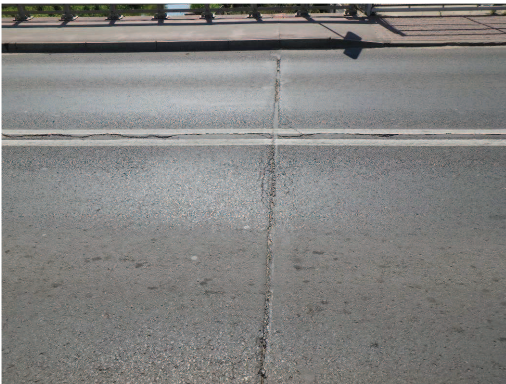
Fot. 23. Widoczne ubytki oraz braki uszczelnienia zdylatowanej jezdni. Uszkodzenia spowodowane niedostosowaniem rozwiązania do przemieszczeń obiektu. Od strony Opoczna.
