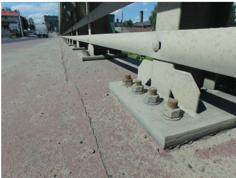
Fot. 25. Widoczne ubytki oraz braki osłon śrub kotwiących barieroporęczę. Brak kapturków na całym obiekcie. Widok od dolnej wody.
