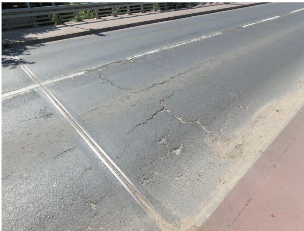
Fot. 10. Widoczne spękania nawierzchni jezdni spowodowane najprawdopodobniej długoletnią eksploatacją oraz błędami wykonawczymi. Uszkodzenia występują na całej długości jezdni.
