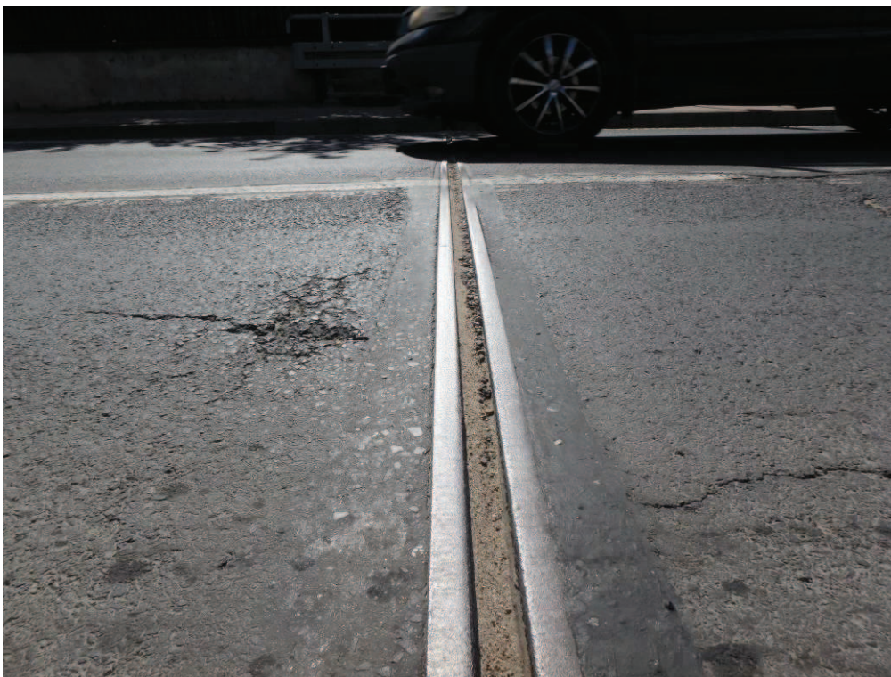
Fot. 19. Widoczne zanieczyszczenia wkładki urządzenia modułowego materiałem ziemnym, ograniczające jego pracę i mogące spowodować przebicie wkładki i nieuszczelnienie urządzenia. Przyczyną jest brak prowadzenia prac z zakresu bieżącego utrzymania.
