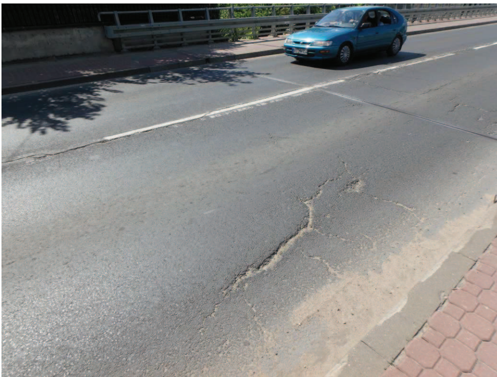
Fot. 6. Widoczne rozległe spękania oraz wykruszenia nawierzchni jezdni w obrębie dojazdów spowodowane najprawdopodobniej długoletnią eksploatacją oraz błędami wykonawczymi. Od strony m. Ogonowice
