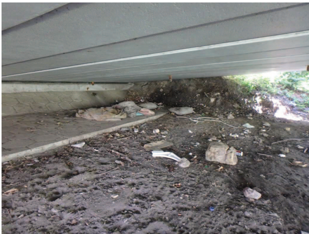
Fot. 42. Widoczne rozległe zanieczyszczenia terenu pod obiektem powstałe na skutek aktów wandalizmu. Dodatkowo widoczny grunt którym w sposób nieprawidłowy obsypano obiekt. Od górnej wody od strony m. Ogonowice
