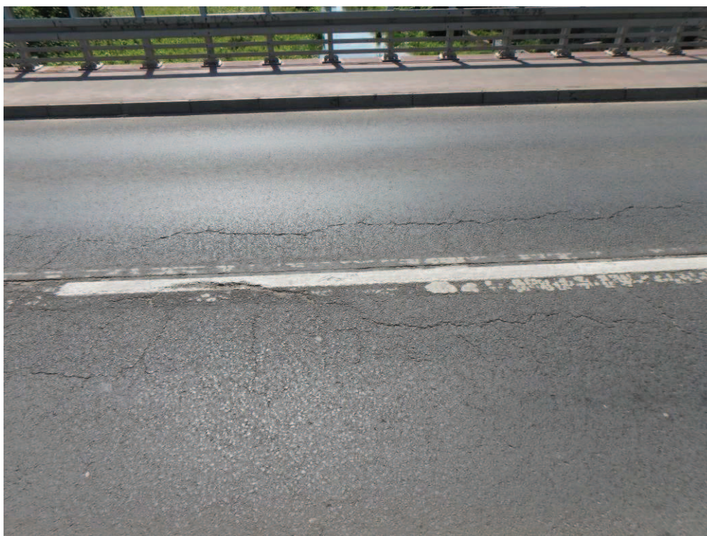
Fot. 9. Widoczne spękania nawierzchni jezdni spowodowane najprawdopodobniej długoletnią eksploatacją oraz błędami wykonawczymi. Uszkodzenia występują na całej długości jezdni.
