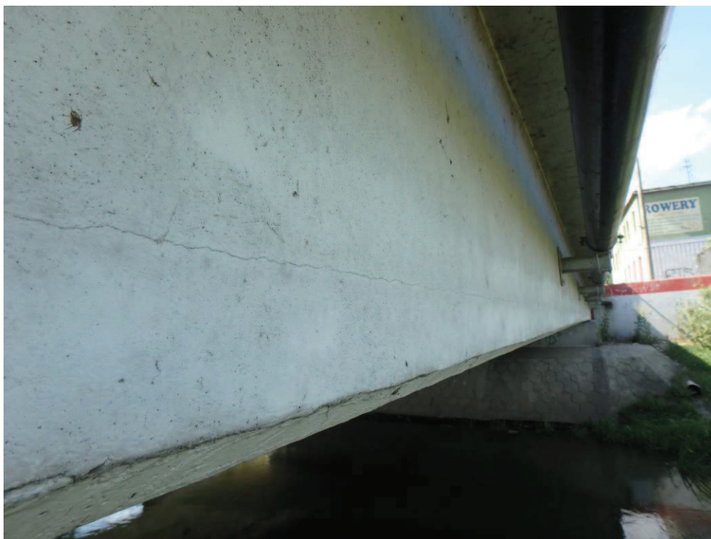
Fot. 33. Podłużna rysa o charakterze technologicznym na połączeniu skrajnej belki z nadbetonem. Uszkodzenie występuje na całej długości przęsła po obu stronach obiektu. Od dolnej wody.
